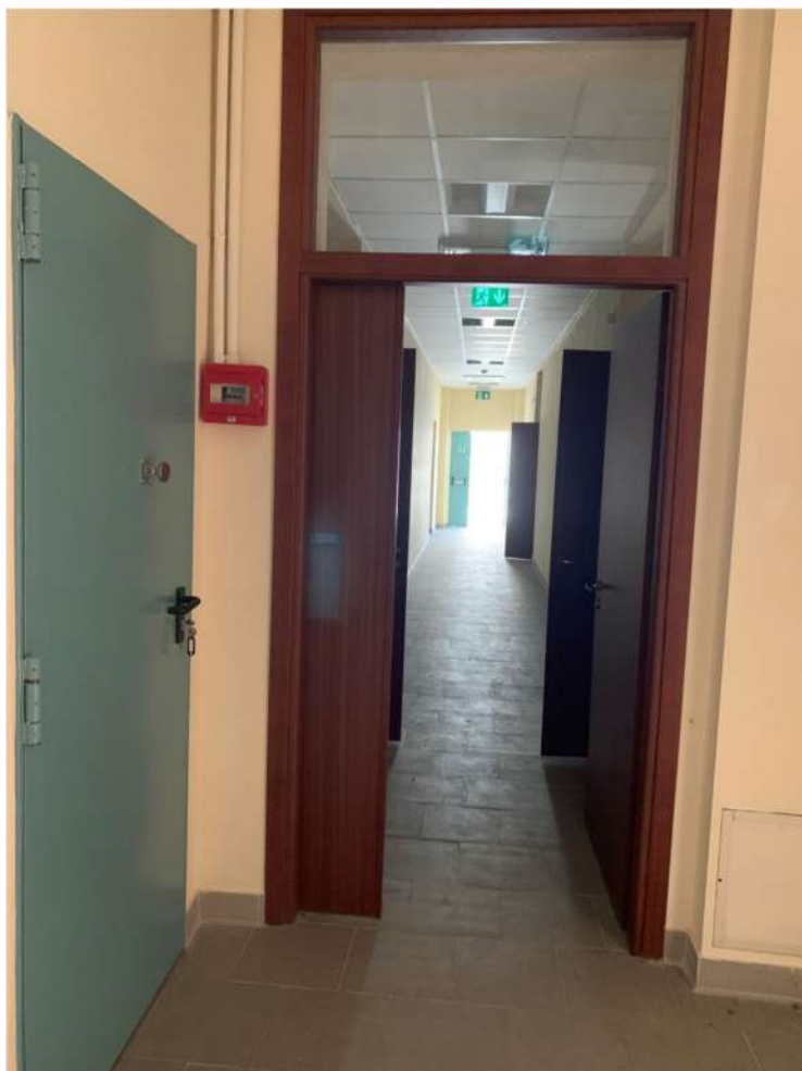
Figura 10 - Vista interna corpo A
