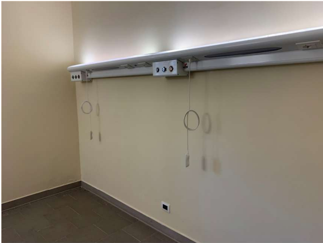
Figura 11 - Locale interno corpo A
