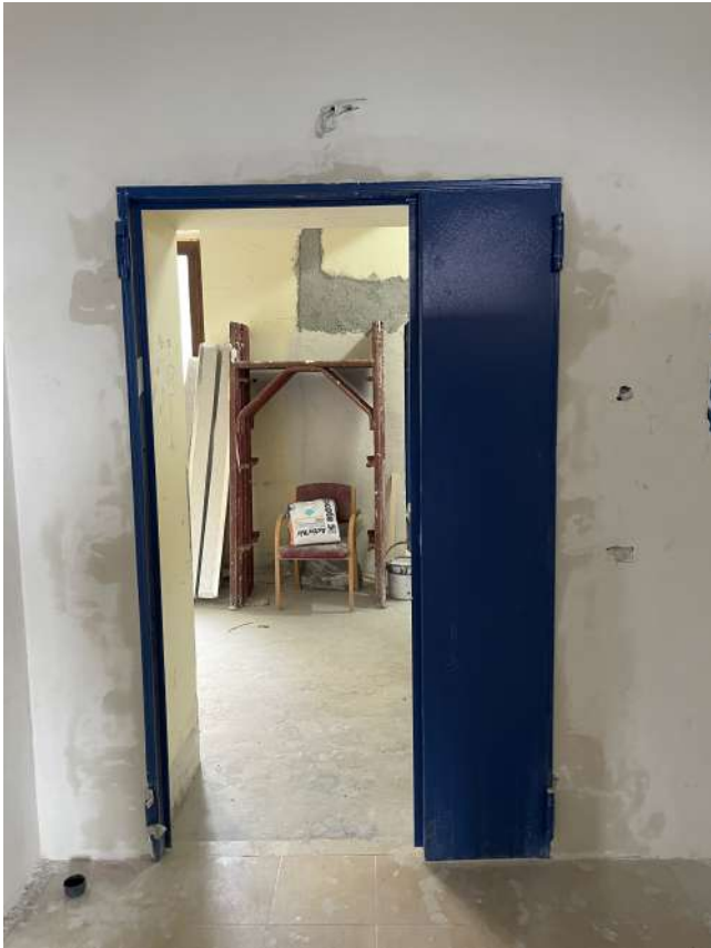
Installazione e giacenza in cantiere delle Porte REI
