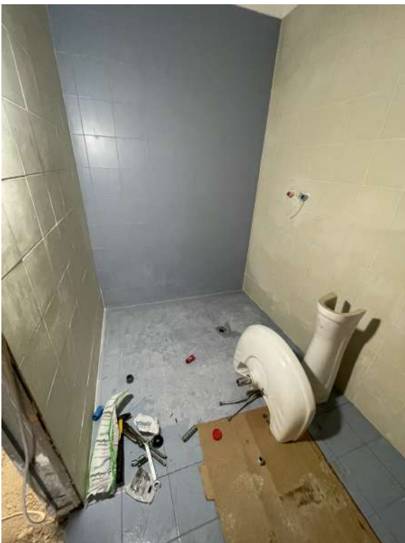
Bagni degenze in fase di istallazione dei sanitari
