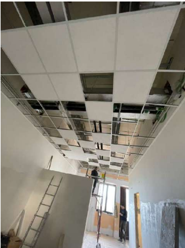
Controsoffitti in stato di avanzamento
