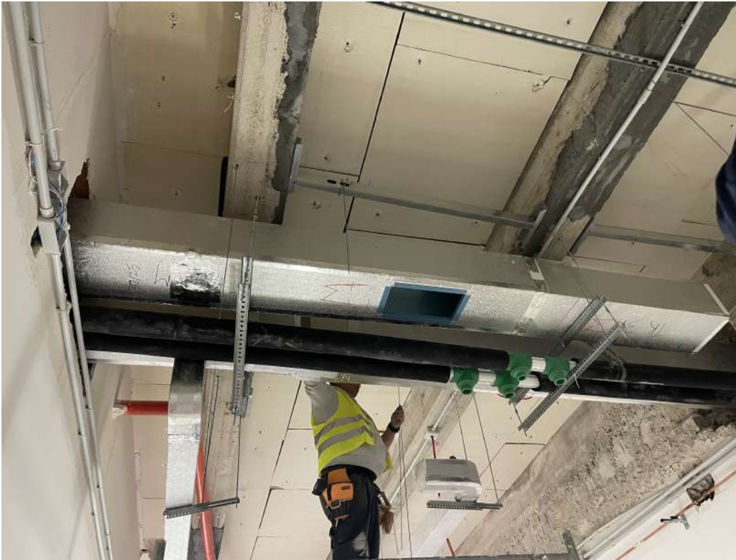
Canalizzazioni idroniche esistenti e passerelle passacavi installate
