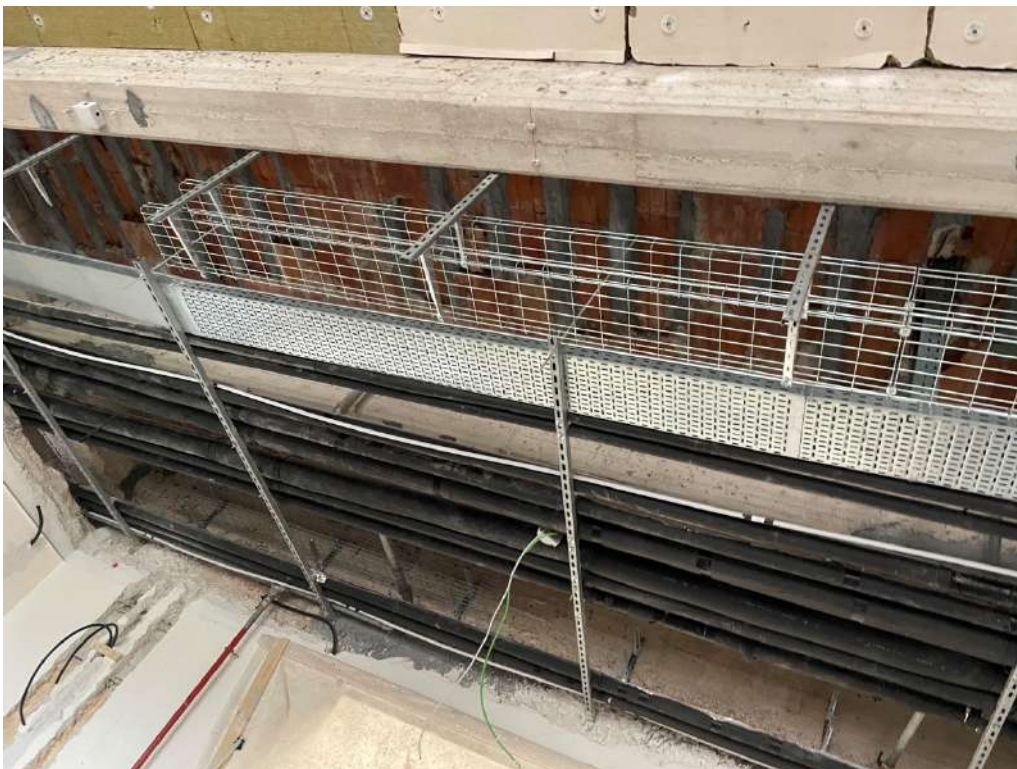
Canalizzazioni idroniche esistenti e passerelle passacavi installate
