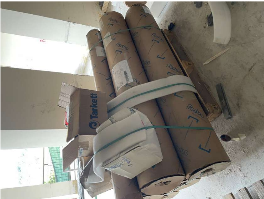
Giacenza in cantiere della fornitura della pavimentazione in linoleum e pareti in pvc
