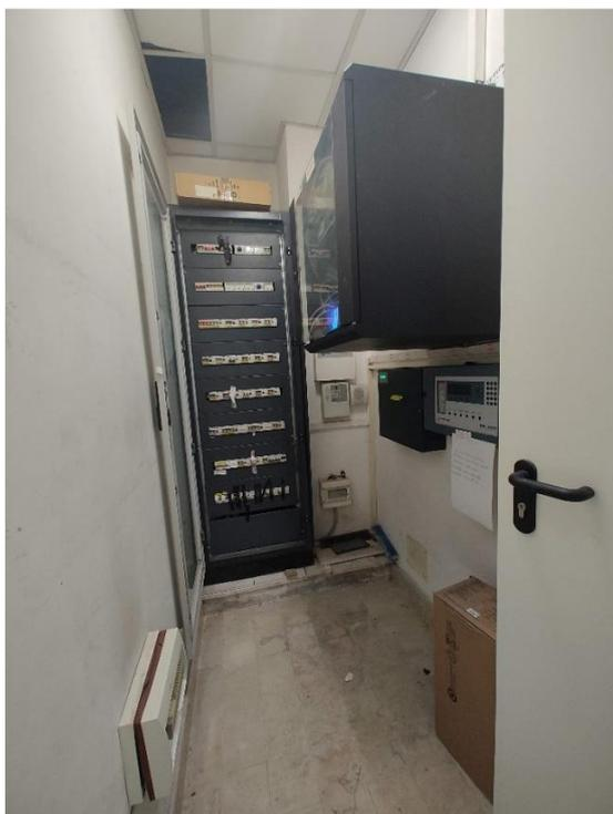
Il locale tecnico del piano terra (foto sopra) è risultato sottodimensionato per accogliere quanto previsto in progetto, ovvero: il quadro di piano, il quadro generale, i rack, l'impianto di videosorveglianza; si provvederà quindi a spostare il quadro di piano in un ambiente limitrofo per una distribuzione ed una funzionalità migliorata dei vari impianti. Inoltre la carpenteria del quadro elettrico esistente non era idonea al riuso quindi è stata prevista nuova e inserita in variante.
