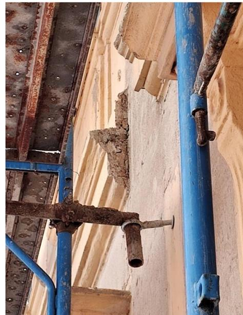
Per completare quindi i prospetti nella loro configurazione ottimale e migliorata è stata inserita in variante anche la lavorazione che riguarda la fornitura e collocazione di tutti gli elementi decorativi realizzati in EPS con superficie finita e posti in opera con tasselli a muro e colla e successiva stuccatura dei giunti, per poi procedere con la tinteggiatura totale di tutte le superfici.
