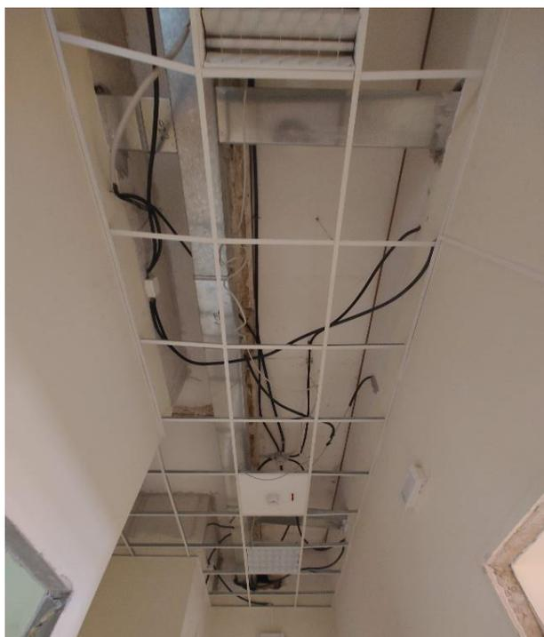
Oltre a creare dei vani molto ampi nella muratura portante, occupavano lo spazio necessario al passaggio di tutto il nuovo sistema di distribuzione degli impianti; quindi per un miglioramento generale sia della struttura che della parte impiantistica sono stati inseriti in variante sia la rimozione delle canalizzazioni che il ripristino della muratura negli attraversamenti.
