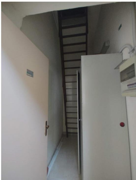
In particolare il locale tecnico al primo piano (foto precedente) è occupato dall'armadio metallico contenente i comandi e il quadro dell'elevatore e dalla scala metallica che dà accesso al sottotetto quindi non può ospitare il quadro di piano; tale quadro, inoltre, è stato revisionato nelle dimensioni poiché si è implementata la dotazione della sala polivalente e della sala PUA/ADI.
