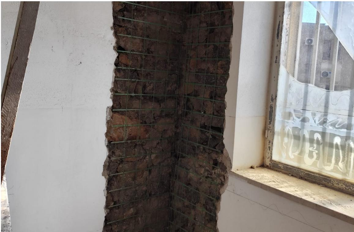
Figura 12 : realizzazione di rinforzo angolare delle pareti perimetrali
