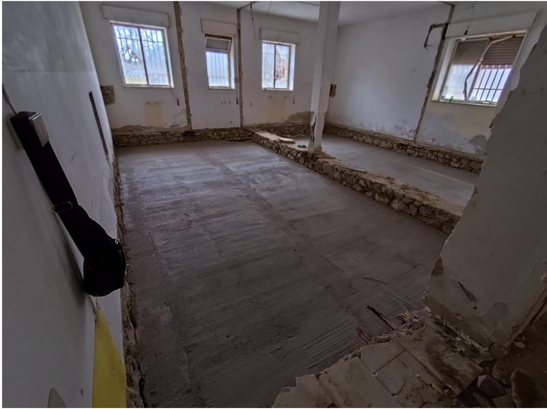
Figura 10 : realizzazione di magrone di sottofondo vespaio areato
