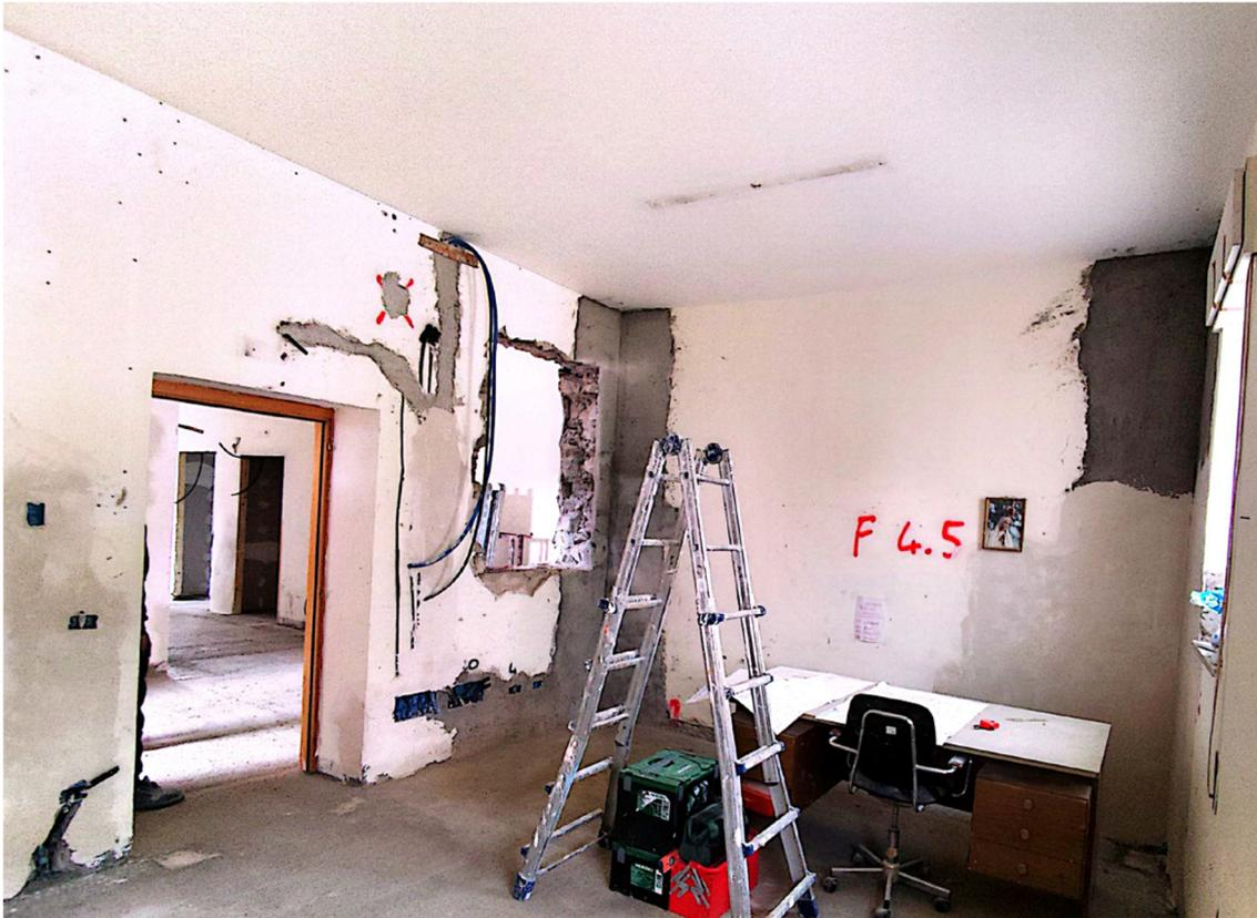
Figura 7 : vista pareti interne non soggette, in progetto a preparazione alla pitturazione
