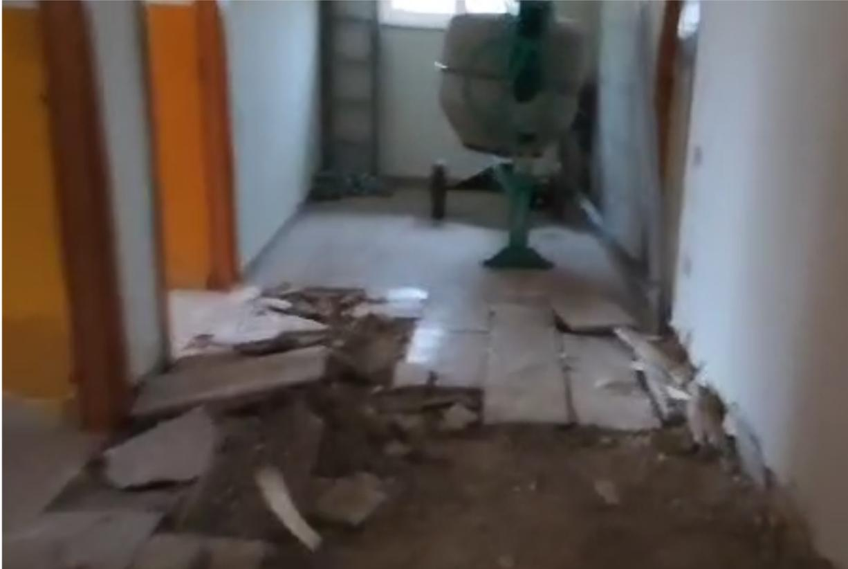
Figura 2 : Vista del massetto esistente sotto pavimentazione del locale n.4
