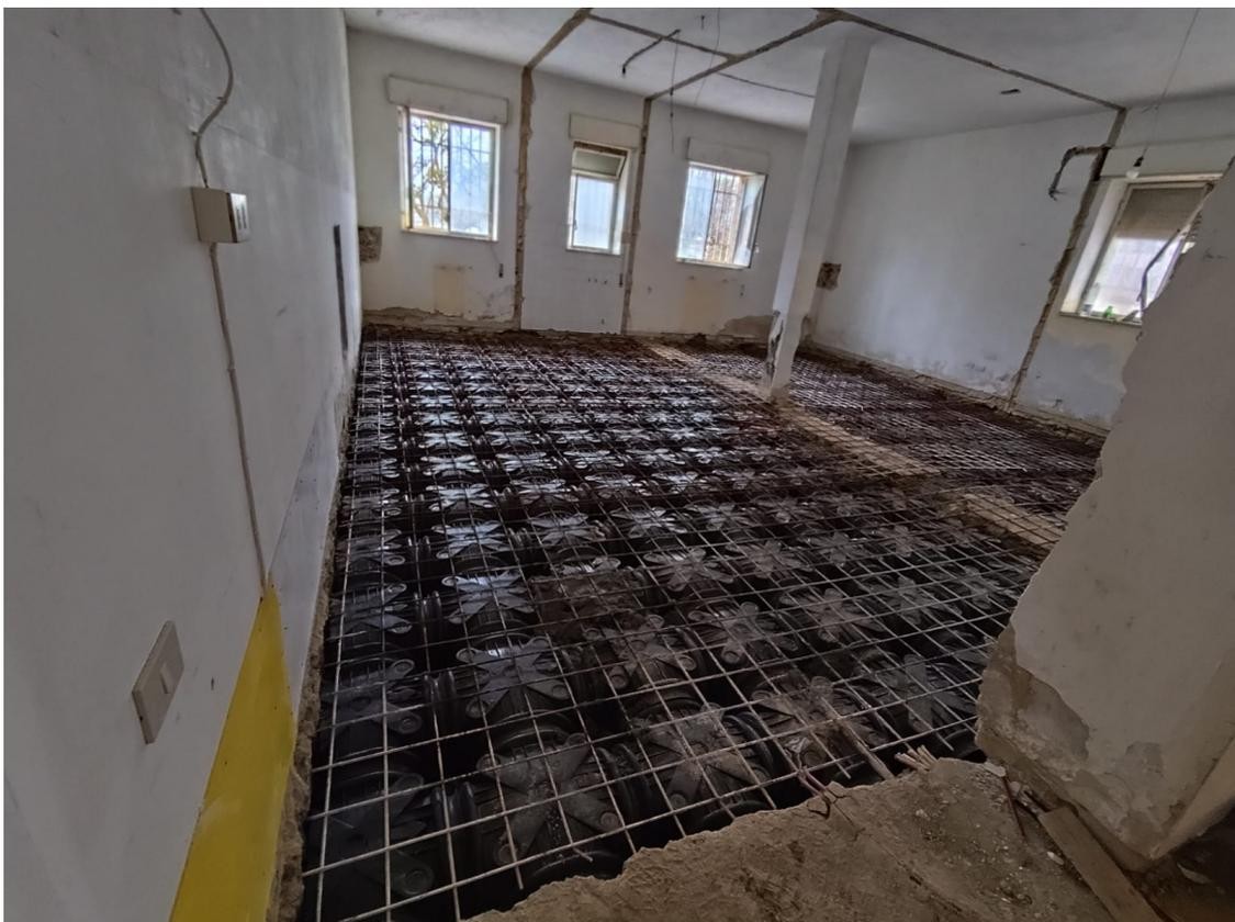
Figura 11 : realizzazione di iglù e piastra superiore di chiusura
