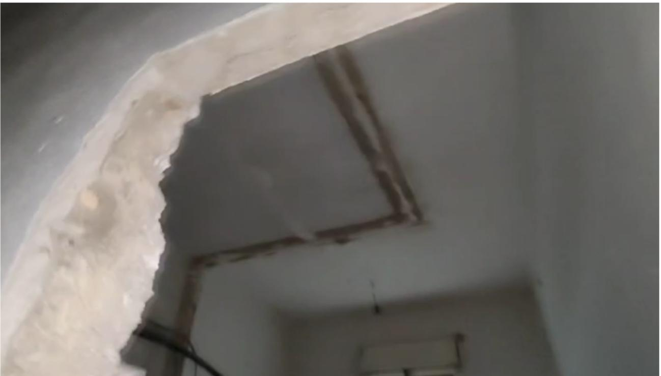
Figura 5 : parete esistente tra loc. 14 e loc. 16 spessore circa 10 cm
