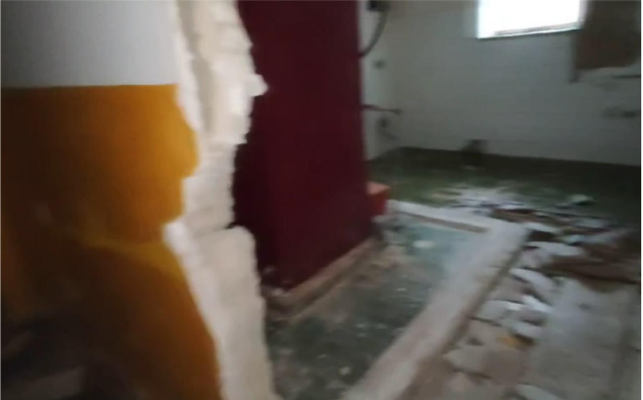
Figura 4 : parete esistente tra loc. 14 e loc. 16 spessore circa 10 cm
