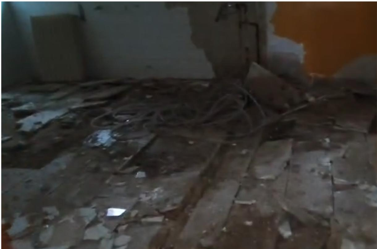
Figura 3 : Vista del massetto esistente sotto pavimentazione del locale n.12
