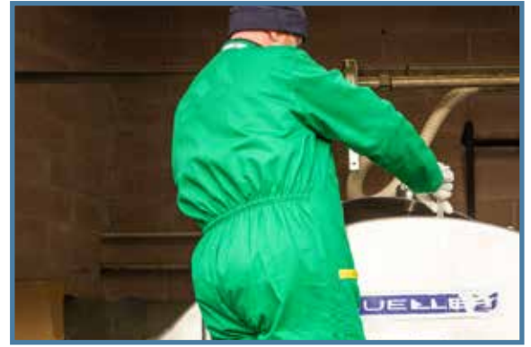
Fig. 55 | Manutenzione del serbatoio di refrigerazione
