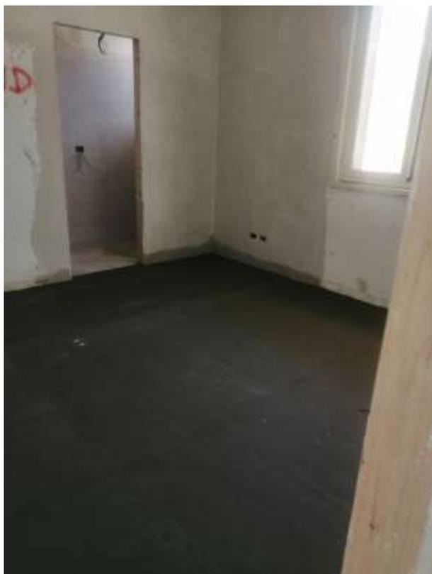
Foto n.5 – Massetto di sottofondo e guaina in pvc
